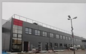
17-11-2022. Skarżysko-Kamienna. Budowa kompleksu utrzymaniowego taboru kolejowego spółki POLREGIO. Fot. Wiktor Tachon
