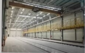
20.03.2023. Skarżysko-Kamienna. Budowa kompleksu utrzymaniowego taboru kolejowego spółki POLREGIO. Fot. Andrzej POLREGIO
