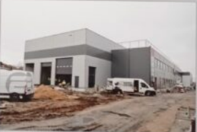
17.11.2022. Skarżysko-Kamienna. Budowa kompleksu utrzymaniowego taboru kolejowego spółki POLREGIO. Fot. Wiktor Tachon
